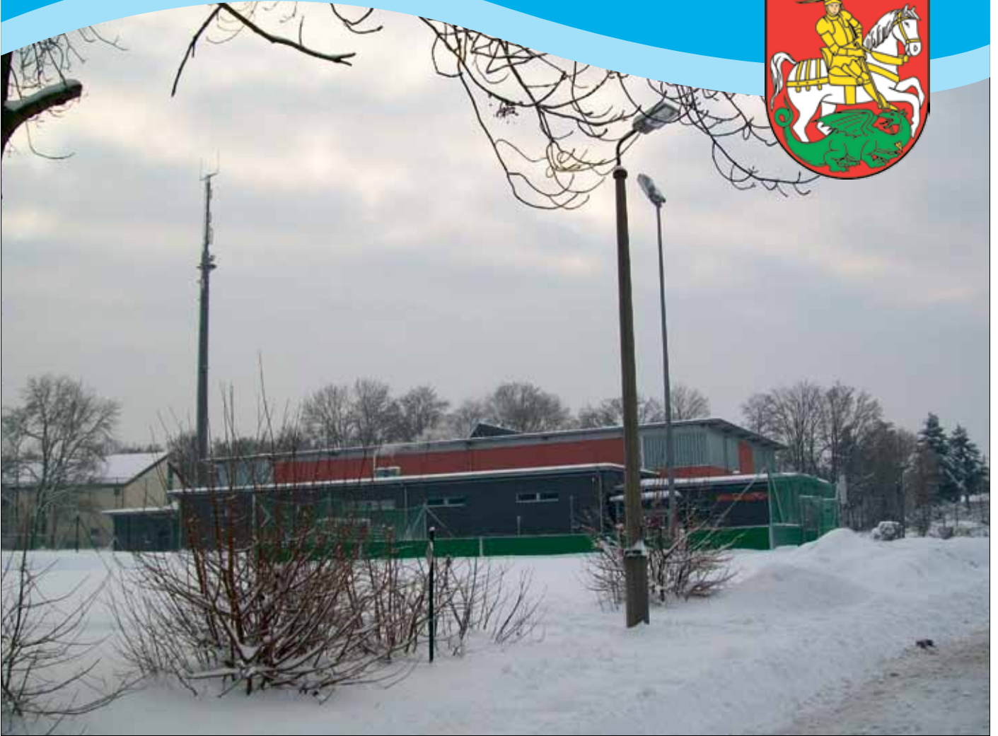
Spangenberghalle in Mansfeld-Lutherstadt, Alte Bergstraße 11, im Winter
